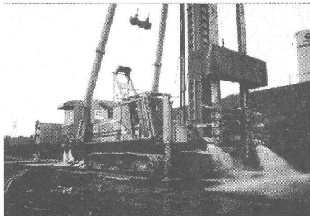
図-3 噴射時の施工機
