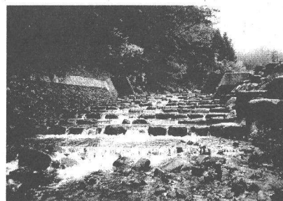
Fig.3 全断面階段式魚道
