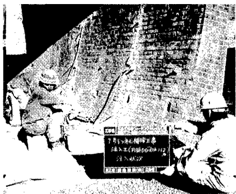
写真－4 ひびわれ注入状況
