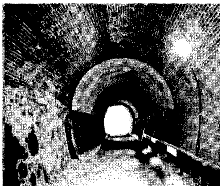
写真－3 支保工・吹付けコンクリート完了
