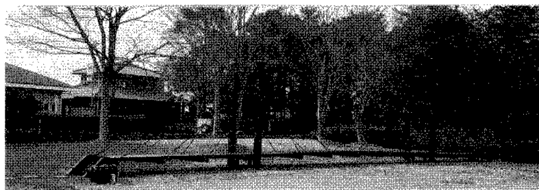
写真－2 木製斜張橋(全長 20m)
