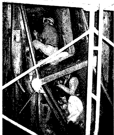
写真-1 PC鋼材設置状況
