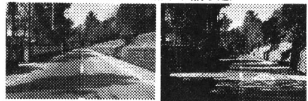
整備前 整備後 写真例-3 日光市(東の参拝道線)
