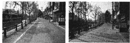
整備前 整備後 写真例-2 栃木市(綱手道)
