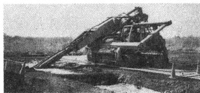
写真-1 施工の状況
