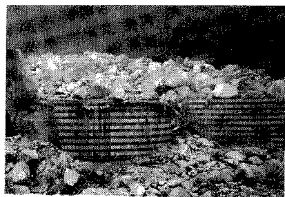
写真－1 セル型砂防ダムの一例
