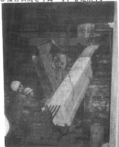
写真一 1 建て込み状況
