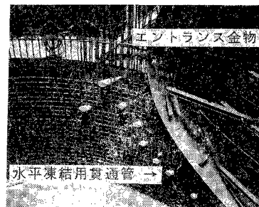
写真-1 配筋状況
