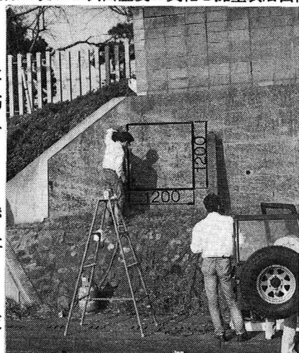
写真-1 熱赤外線センサによる擁壁面の観測状況
