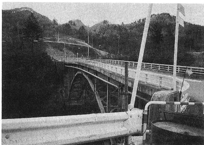
写真-1 被災した龍宮橋（中央部が盛り上がっている）
