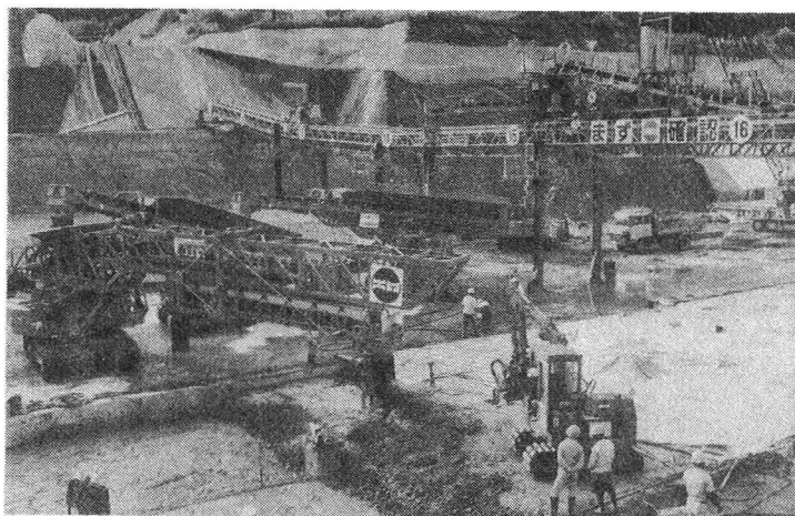
写真-3 旋回コンベヤ→中継コンベヤ→スプレッドコンベヤ→打設
