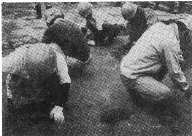
写真-1 小型鉄による着岩面の平坦仕上げ
