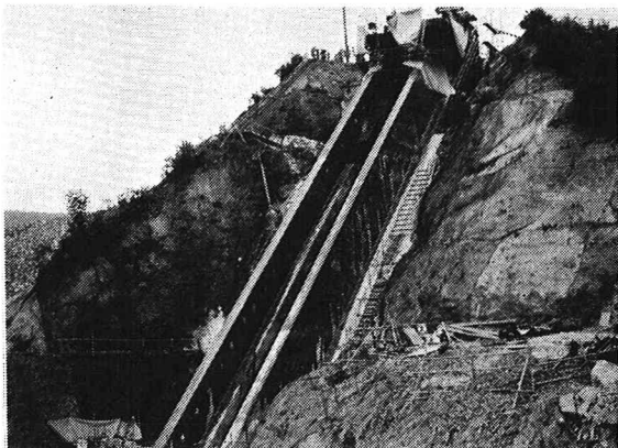
写真-2 完成した取水口設備
