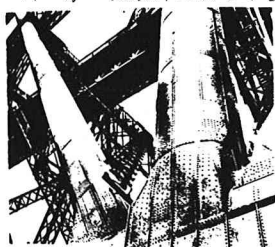
フォース橋の脚部構造 (写真-2)
