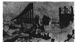
崩壊したテイ(Tay)橋(写真-1)
