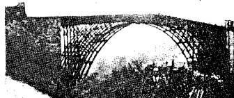
図-8 世界最初の鋳鉄橋アイアン・ブリッジ（技術叢書、No.291より）
