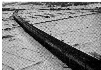
写真1 試験用高架橋
