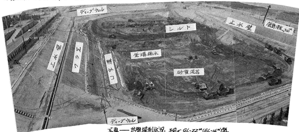
写真— 岩盤掘削状況 事前# GL-22m(EL-14m)盤
