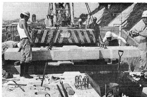
写真-3 プレキャストスラブの敷設
