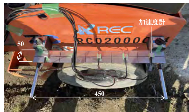
図-3 ローラ側面 加速度計の設置状況
