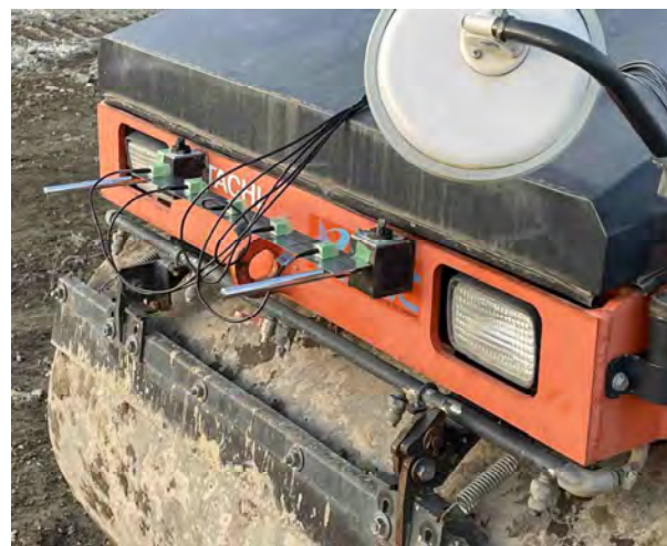
図-9 ローラー前面 加速度計の設置状況
