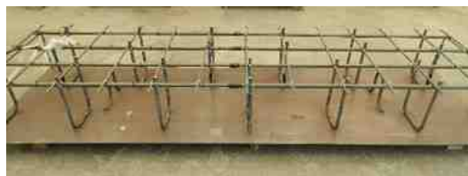
写真-1 ずれ止め筋配置状況
