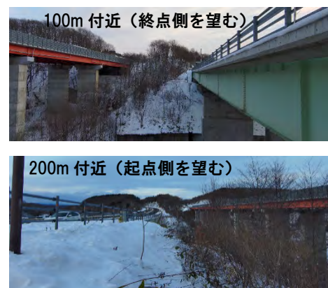
図-13 撮影したドローン画像
