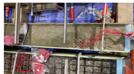
写真-2 靱性モルタルによる増厚施工
