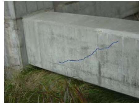
写真-1 ラーメン高架橋の被害の例
