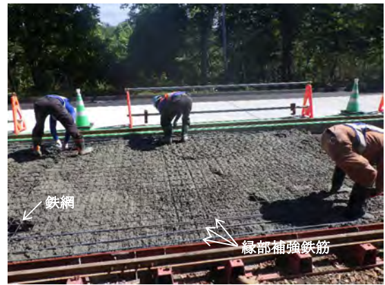
写真-2 鉄網および縁部補強鉄筋の設置
