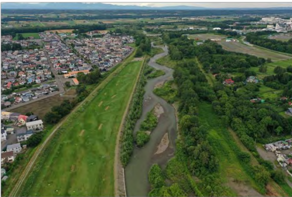
図-1 大成橋-美生橋間の空撮画像 (2022/08/11)
