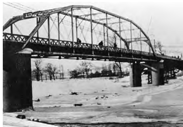
写真-1 初代旭橋
