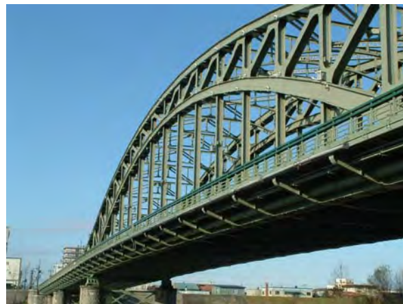
写真-4 現在の旭橋
