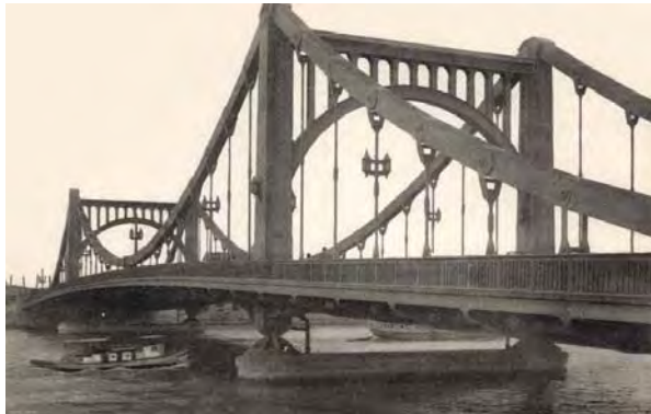
写真-7 清洲橋 (昭和 3 年竣工)
