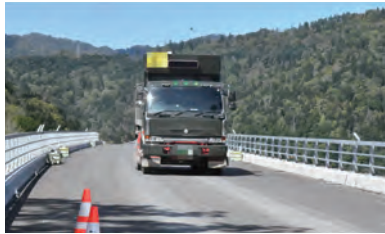
写真-2 大型車両による加振状況
