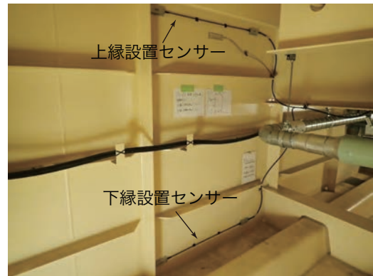
図-6 上下縁ひずみ測定用センサ設置状況
