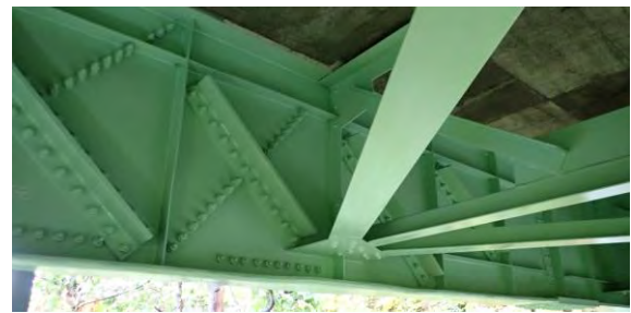
写真-2 腹板補強材の設置状況
