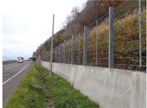
写真-1 従来型落石防護柵
