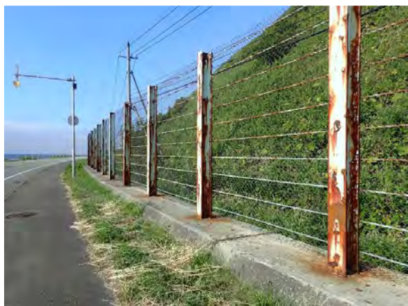
写真-2 撤去される前の落石防護柵の状況
