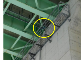
支承点検状況
