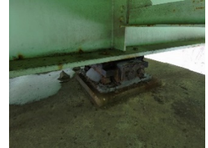
支承確認写真
