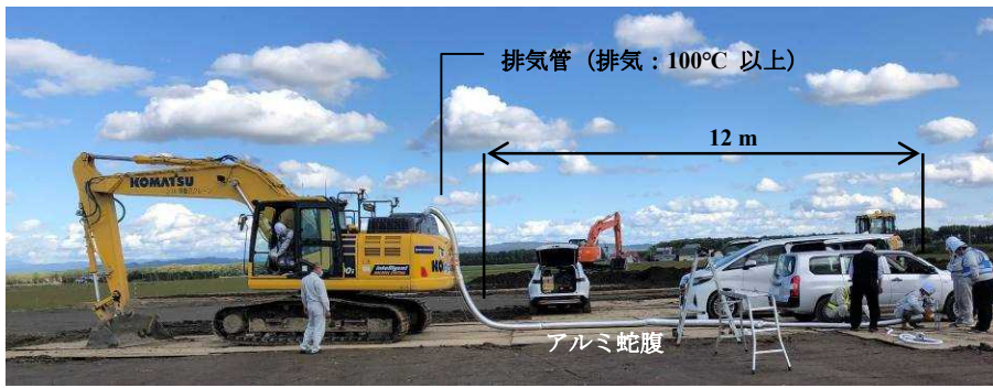
図-1 バックホーCO 2 排出量測定状況
