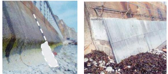
写真-1 摩耗による欠損 写真-2 補強後の状況
