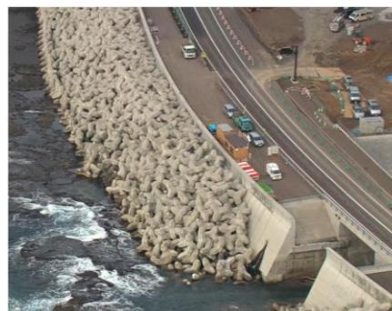
写真-4 高波作用後の消波護岸の状況
