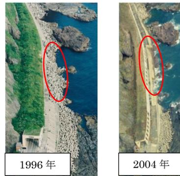
写真-1 大森覆道の被災前後の消波ブロックの状況
