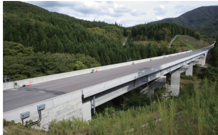
写真-1 対象橋梁の全景
