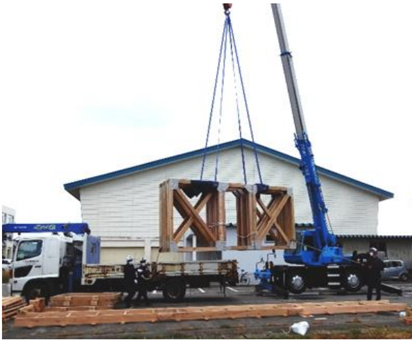
写真-2 架設台上へ降ろす作業
