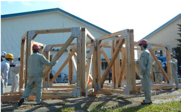
写真-3 架設台上で橋を展開
