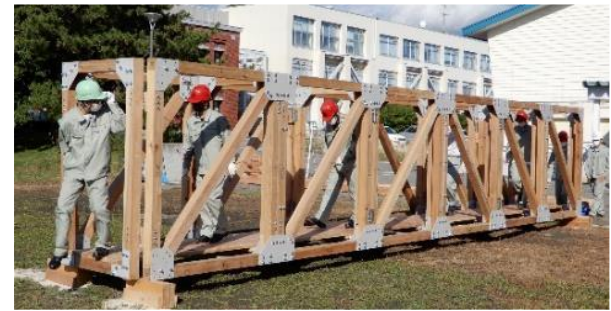
写真-5 完成時の状況
