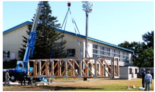
写真-4 クレーン一括架設
