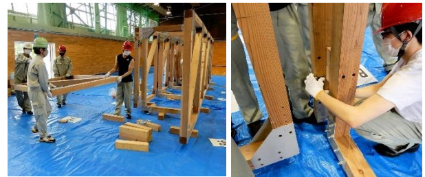
写真-1 組立作業の状況
