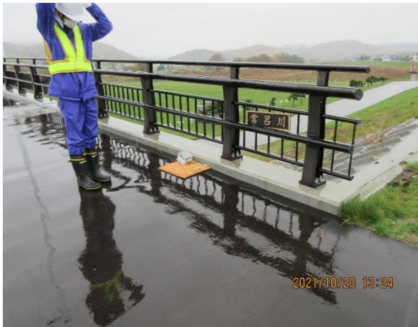
写真-1 センサユニット設置状況 (橋面上)
