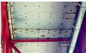
写真-2 広範囲に損傷(さび)が見られる橋梁例
