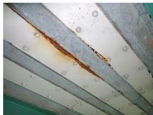
写真-3 局所的に損傷(さび)が見られる橋梁例
