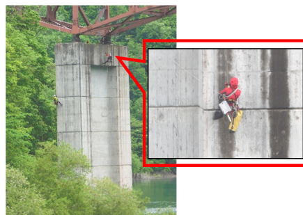
図-2 クライミング点検による高橋脚での作業状況
