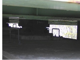
中桁支承確認写真
