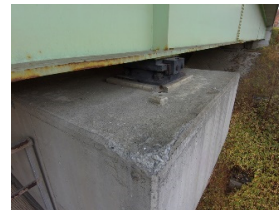
外桁支承確認写真
