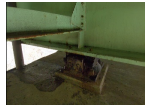
中桁支承確認写真
