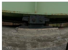
支承確認写真
