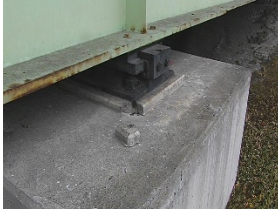
外桁支承確認写真
