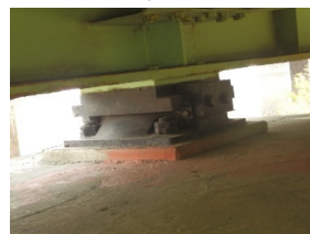
支承確認写真
