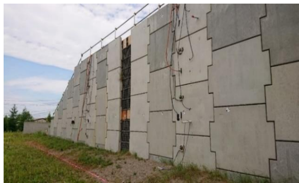
図-1 対象構造物のコンクリート製補強土壁
