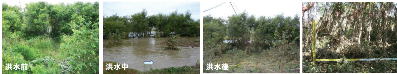
写真3 樹林帯内流速観測測線 (KP2.843 測線) における樹木状況
