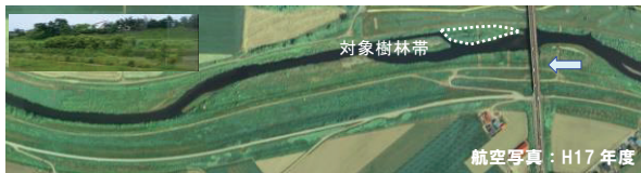
写真2 調査箇所における樹木繁茂状況 (左: 航空写真 右: 右岸からの状況)
