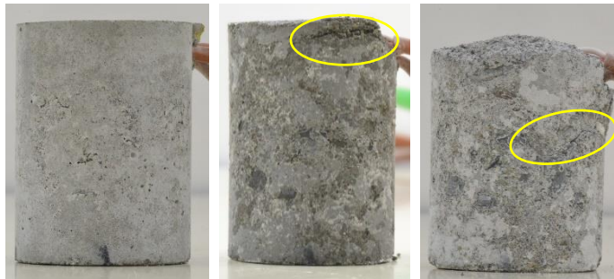
(a) 実験前 (b) 100 サイクル後 (c) 125 サイクル後 図-5 供試体 0.8-A の側面の劣化状況
