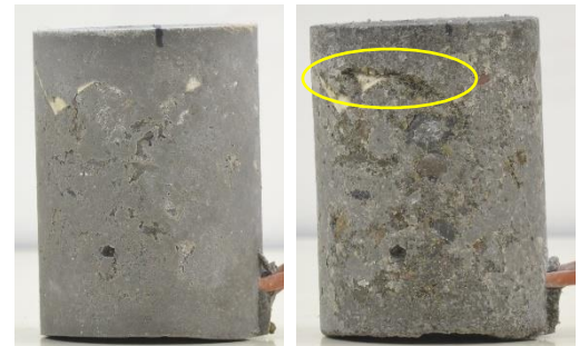
(a) 実験前 (b) 125 サイクル後 図-6 供試体 0.8-B の側面の劣化状況
