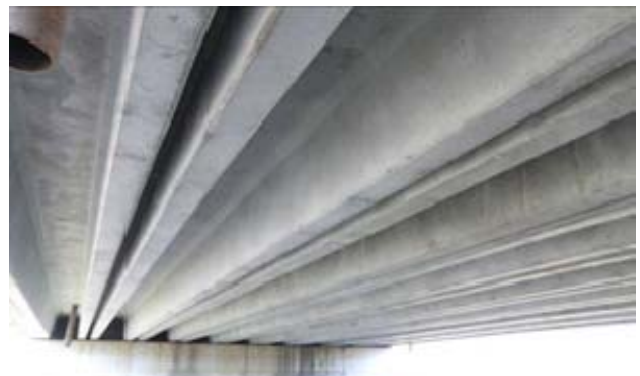
(b) 主桁 図-2 B 橋
