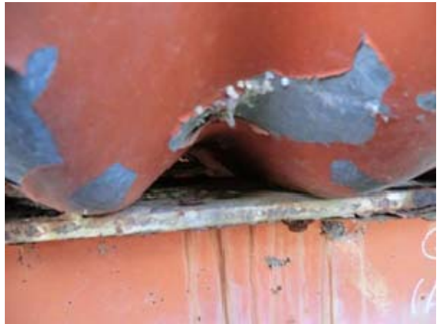
(b) 床版と上フランジの接合部 図-4 D橋
