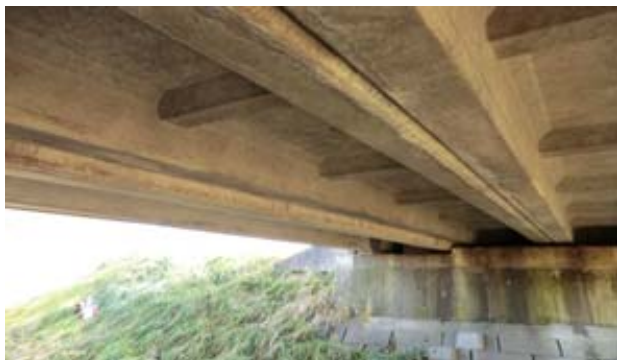
(b) 主桁 図-1 A 橋
