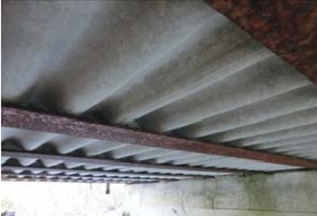
(b) 主桁・床版底 図-3 C橋
