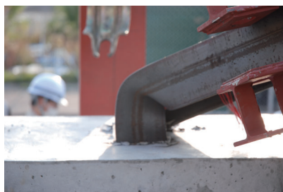
(d) PS 試験体の基部の変形状況-2
