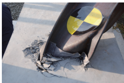
(c) PS 試験体の基部の変形状況-1
