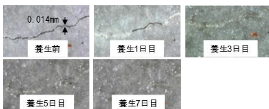
図-6 H2-1 ひび割れ閉塞状況
