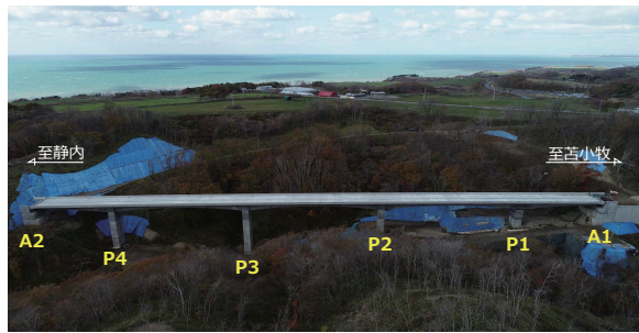
写真-1 橋梁の全景
