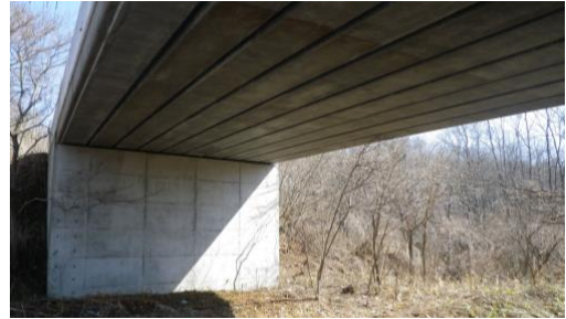
写真－1 対象橋梁（桁下の状況）
