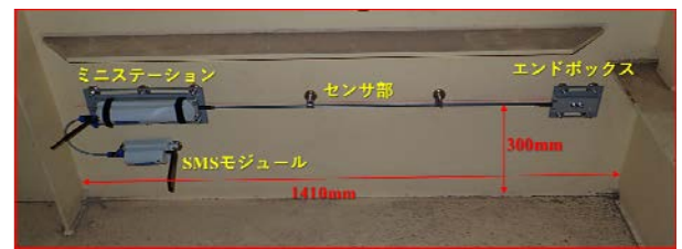
写真-2 計測機器の設置状況
