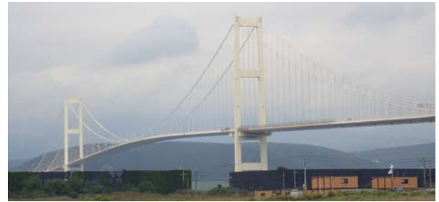
写真-1 白鳥大橋の全景
