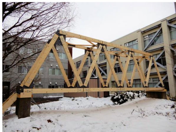
写真-1 完成時の状況
